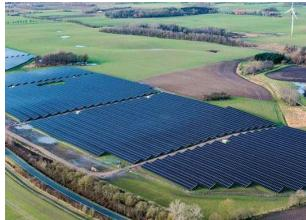
Grundflächen-Photovoltaikanlage auf einer Fläche von 7.495 m<sup>2</sup> mit einer Anlagenleistung von rd. 24.397 Kilowatt-Peak (kWp)
